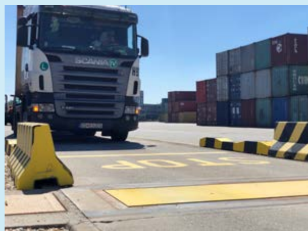
Sistem WIM de viteză mică în METRANS Dunajská Streda
