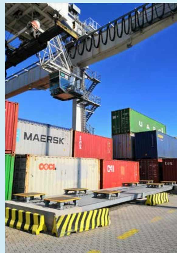
Instalarea sistemului de cântărire a containerelor în METRANS Praga, Republica Cehă
