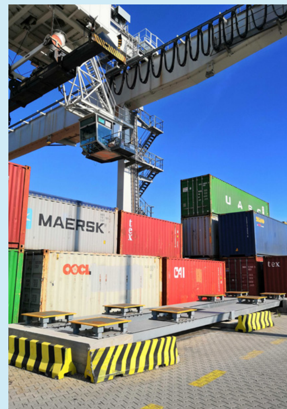
Instalacja systemu ważenia kontenerów w METRANS Praga, Republika Czeska.
