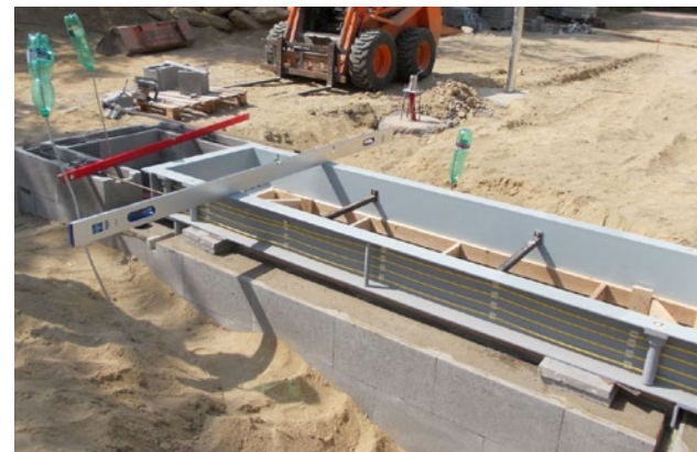
Monolitický základ vah za použití „ztraceného bednění“. Na základové vaně je vyrovnan základový rám vah, vlevo od rámu (směrem k váhovně) je vidět základ pro revizní šachtu
