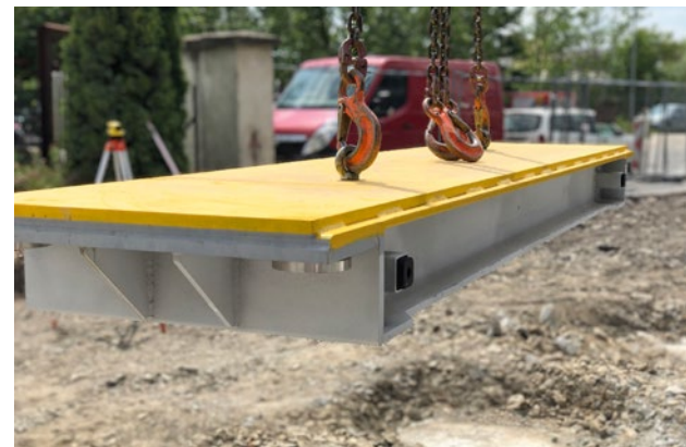
Můstek vah před usazením do rámu
