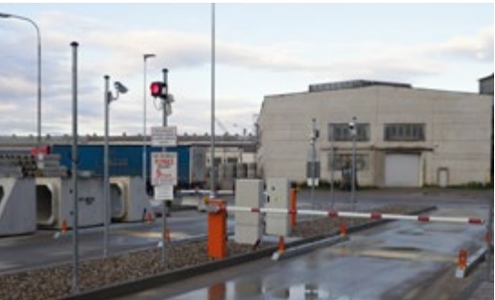
Stanoviště vah v závodě Českomoravský beton, a.s. - betonárna Grygov
