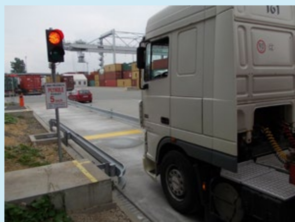
Nízkorychlostní nápravový WIM systém v METRANS Česká Třebová
