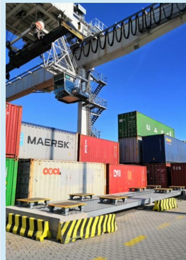
Instalace kontejnerového vážicího systému v METRANS Praha, Česká republika.
