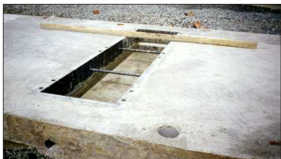
Instalacija osnovnog rama u mernu zonu Tačnost vage uslovljava pre svega pažljivo postavljanje rama i ravnine merne zone.
