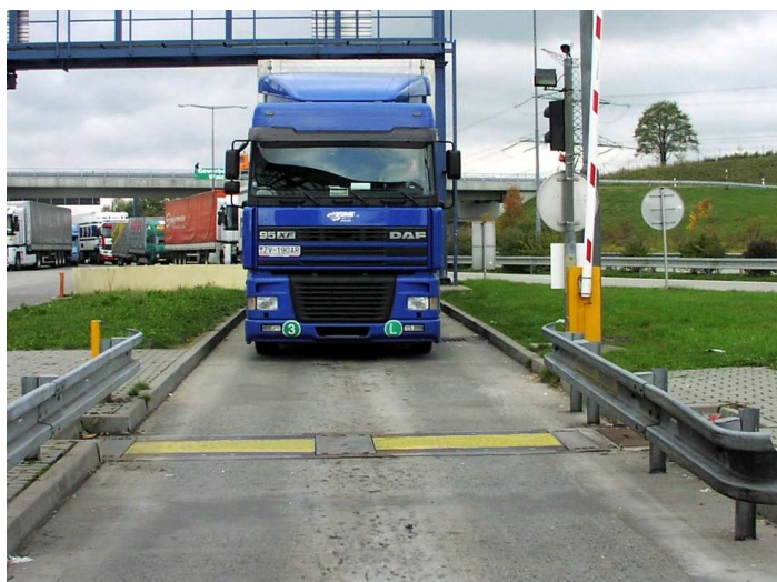
obr. 1: Provoz přes váhy VM-2.2 zabudované do vážení zóny na HP (zde HP Rozvadov)
