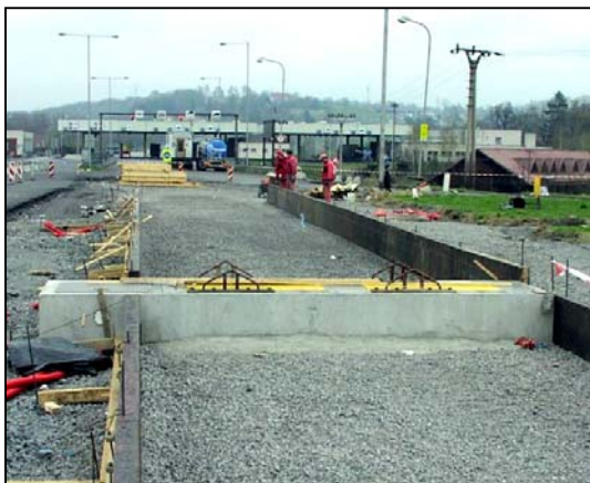
obr. 3 a 4: Instalace váhy VM-2.2 do vážní zóny a provoz přes váhu rychlostí až 16km/h
