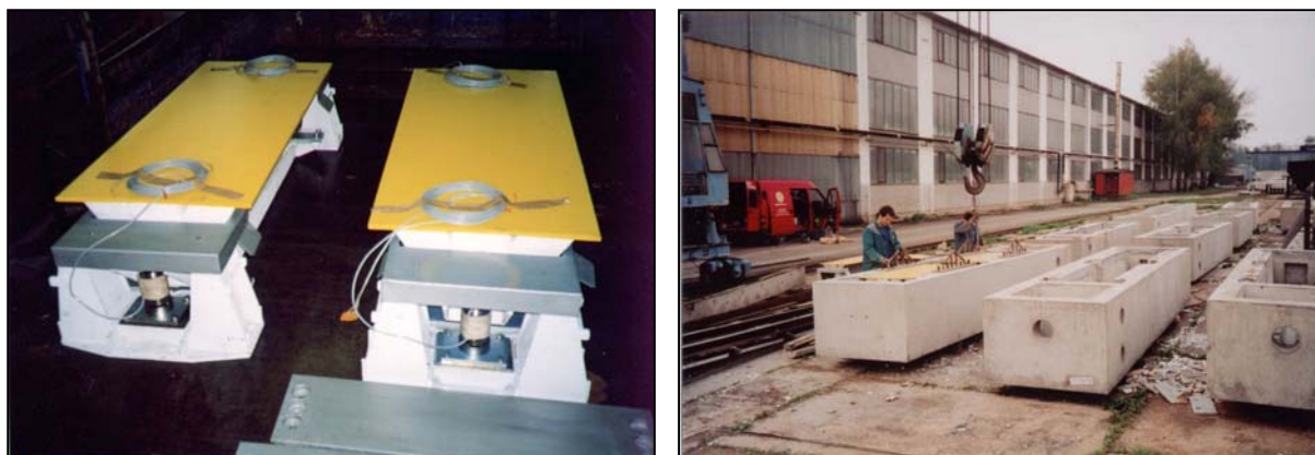
obr. 3 a, b: Výroba silničních vah VM-2 a jejich ukládání do prefabrikovaného základu vah
