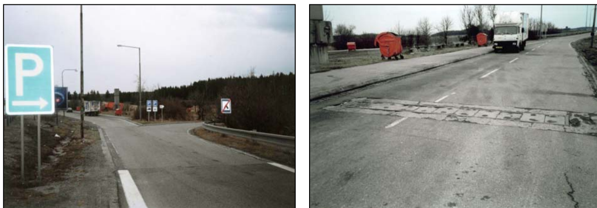
obr. 2 a, b: Pokus z počátku 80. let zřídit vážící místo na dálnici D1 (odpočívka na 190 km ve směru do Brna)
