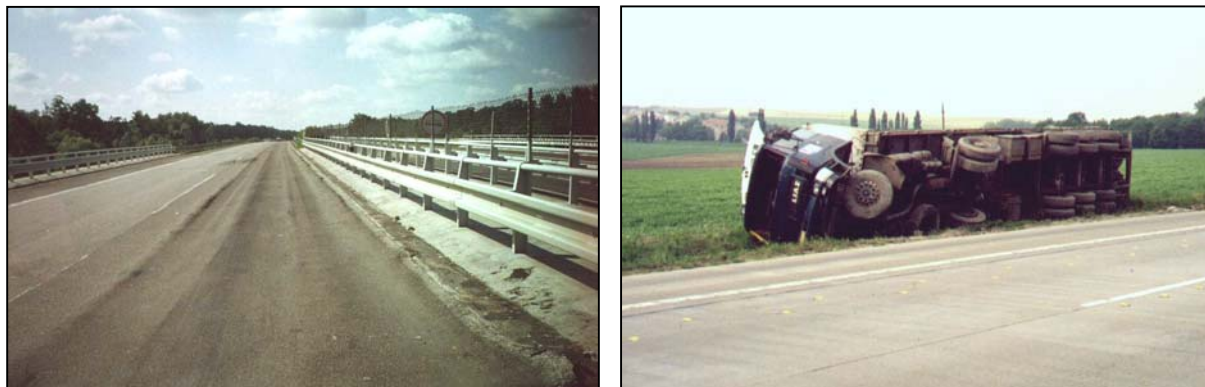
obr. 1 a, b: Důsledky nekontrolovaného přetěžování nákladních vozidel
